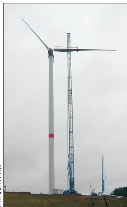
Montáž listů rotoru elektrárny
