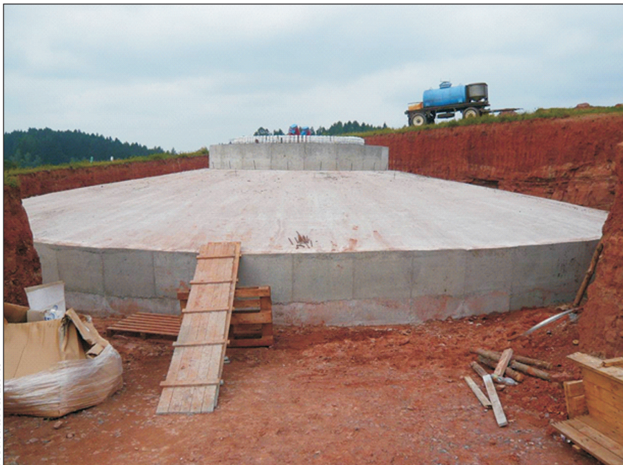
Dokončený železobetonový základ větrné elektrárny před zahrnutím zeminou
